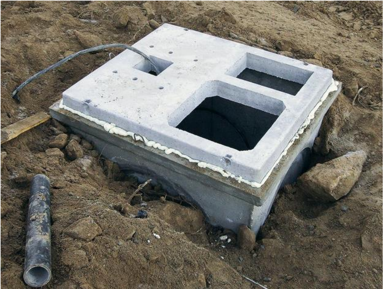
Bild oben: Schacht für die Montage der fixen Schneeerzeuger
